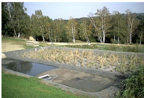
Obr. 7 Kalová pole po rekonstrukci
