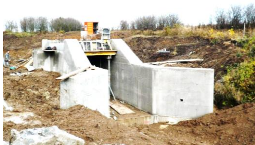
Obr. 10 Stavba železobetonového výpustního objektu s bezpečnostním přelivem (po betonáží)
