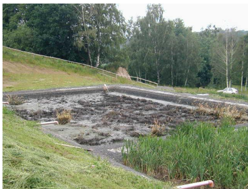
Obr. 5 Kalová pole před rekonstrukcí
