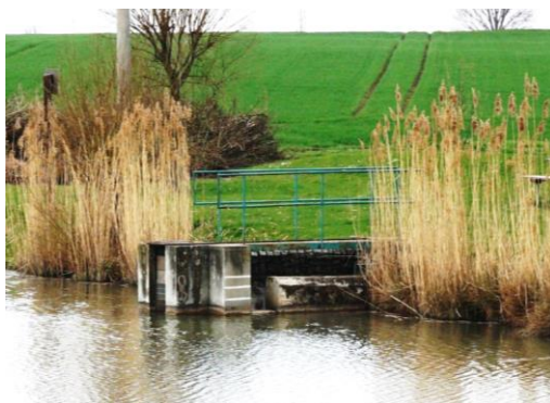
Obr. 15 Výpustný objekt s bezpečnostním přelivem
