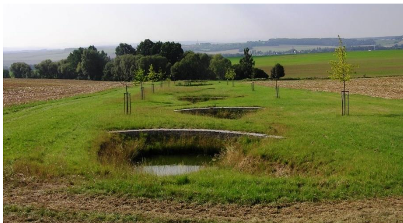
Obr. 12 Vsakovací jámy těsně po realizaci 2014 (foto: archiv KPÚ Pro Plzeňský kraj, Pobočka Plzeň)
