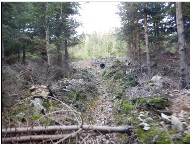
Obr. 4 Voda z propustků by měla odtékat nesoustředěným odtokem, ne uměle vytvořeným korytem
