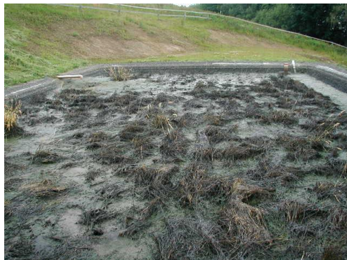
Obr. 6 Detail kalového pole s úhynem makrofyt (rákosu) v první etapě provozu
