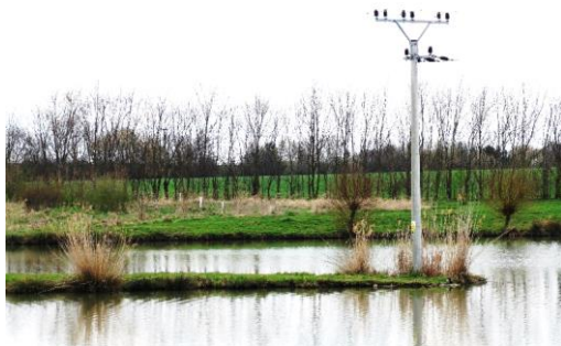
Obr. 16 Vedení 22 kV
