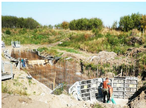
Obr. 9 Stavba železobetonového výpustního objektu s bezpečnostním přelivem (před betonáží)
