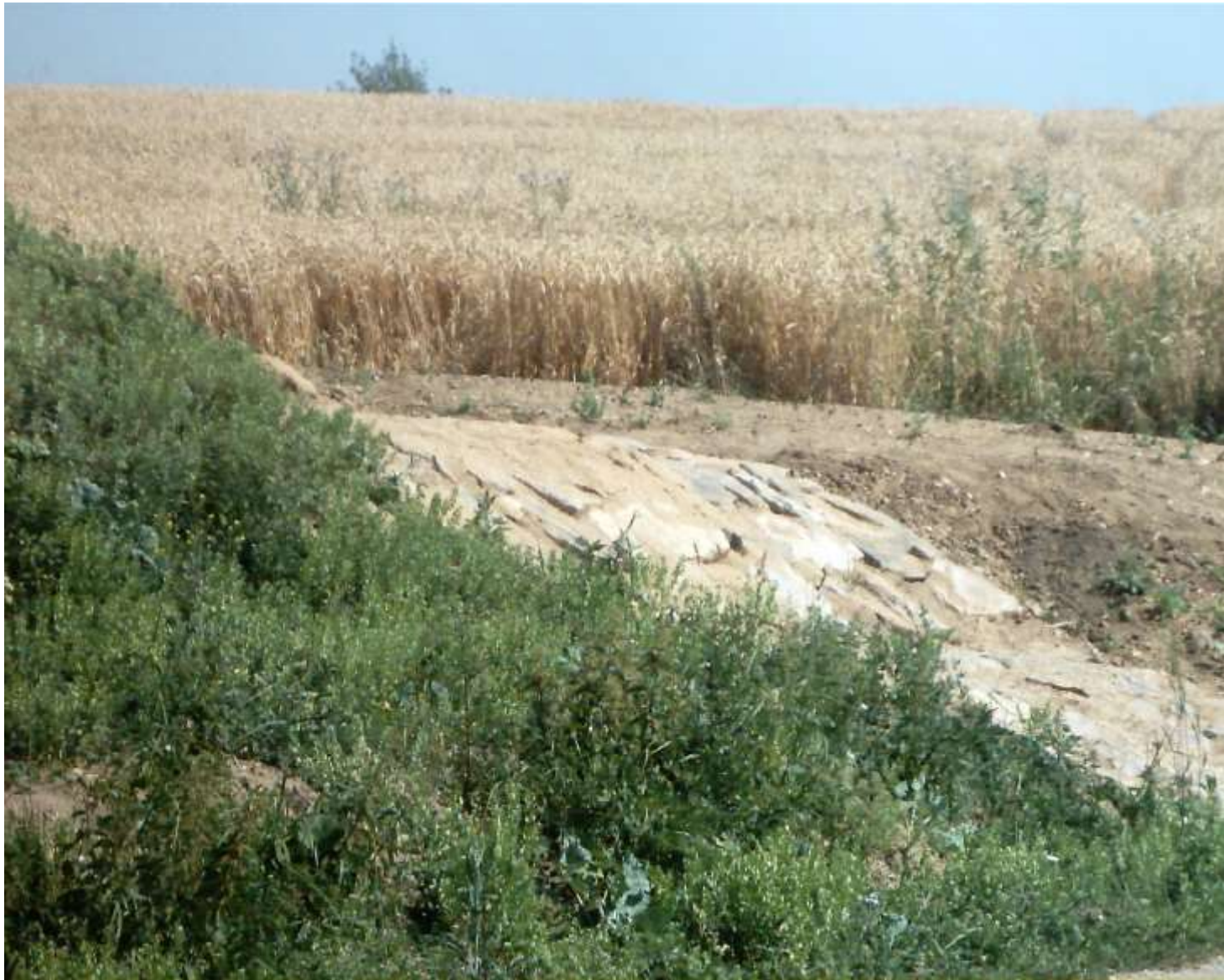
Nouzový přeliv v zavázání hráze
