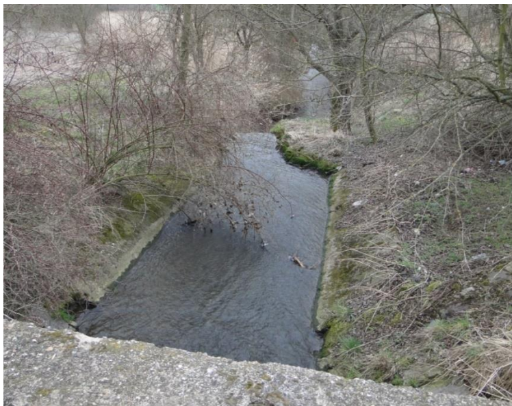
původní stav koryta
