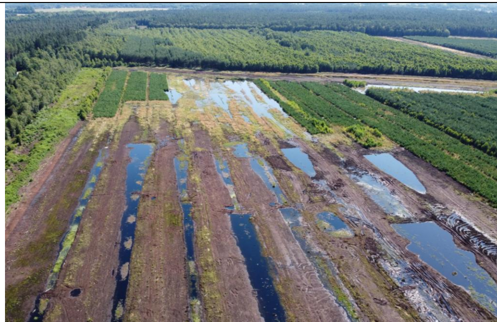
Revitalizace těžebny rašeliny Hrdlořezy – I. a II. etapa, celkový pohled
